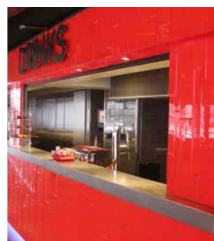
Kool - Ahoy Rotterdam - Revestimiento epoxi 2K
