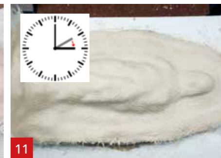
8 ...en druk een tweede laag A1 Triaxial glass fibre in de nog natte A1.
