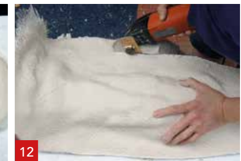
9 Druk de A1 Triaxial glass fibre stevig aan. Het weefsel laat zich goed vormen/modelleren.
