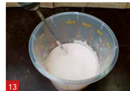
13 Die A1 Mischung ist einsatzbereit, wenn sich alle Klumpen aufgelöst haben.
