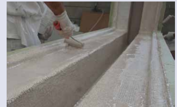
Für die Laminierung müssen Sie nass-in-nass arbeiten. Mit einer Bürste oder einem Farbroller können Sie das A1 sehr zügig auftragen.
