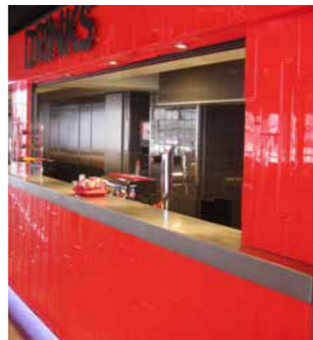
Kool – Ahoy Rotterdam – 2K Epoxidbeschichtung
