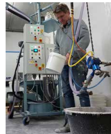
Sprühen mit zerkleinerten Fasern
