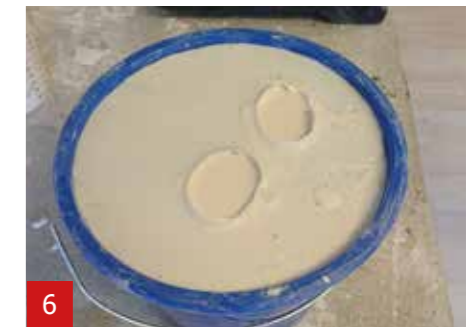
6 Lassen Sie die A1 Masse ungefähr 1 Stunde trocknen.
