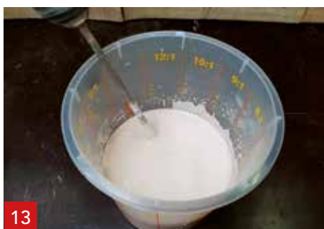
13 A1 jest gotowy do zastosowania, gdy znikną wszystkie grudki.
